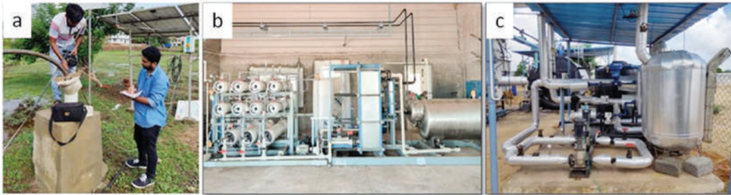
चित्र. क) नावेलिम गोवा साल नदी स्थल पर आर बी एफ कुओं। .ख) फॉरवर्ड ओसमोसिस सिस्टम नारिपैयायूर विलेज, रामनाथपुरम जिला, तमिलनाडु में स्थापित किया गया। ग) नरिपैयायूर ग्राम, रामनाथपुरम जिला, तमिलनाडु में सौर गर्म पानी की व्यवस्था स्थापित की गई
